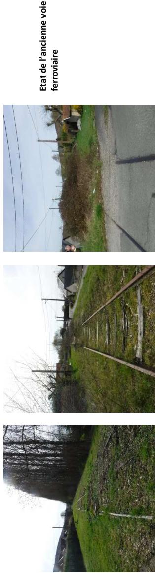
Avec les années sans circulation, certains équipements manquent ponctuellement (notamment au niveau des passages à niveau). Sur la majeure partie du tracé, le ballast et les traverses sont envahis et recouvert par la végétation qui gagne du terrain. Néanmoins, le ballast est présent sur la majeure partie du linéaire et présente une certaine régularité.
